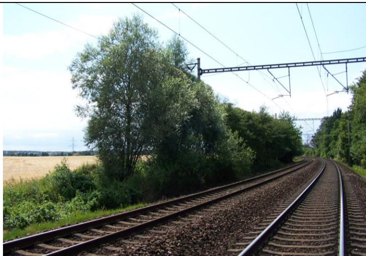
Obr.19-porost v oblouku tratě kolidující s rozhledovými poměry, dřeviny č.384-387, km 288,7-288,5
